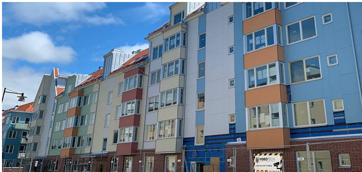
Amhult 2 utvecklar ett nytt stadsdelscentrum i utkanten av Göteborg. På bilden syns bolagets fastighet Kvarteret India.
