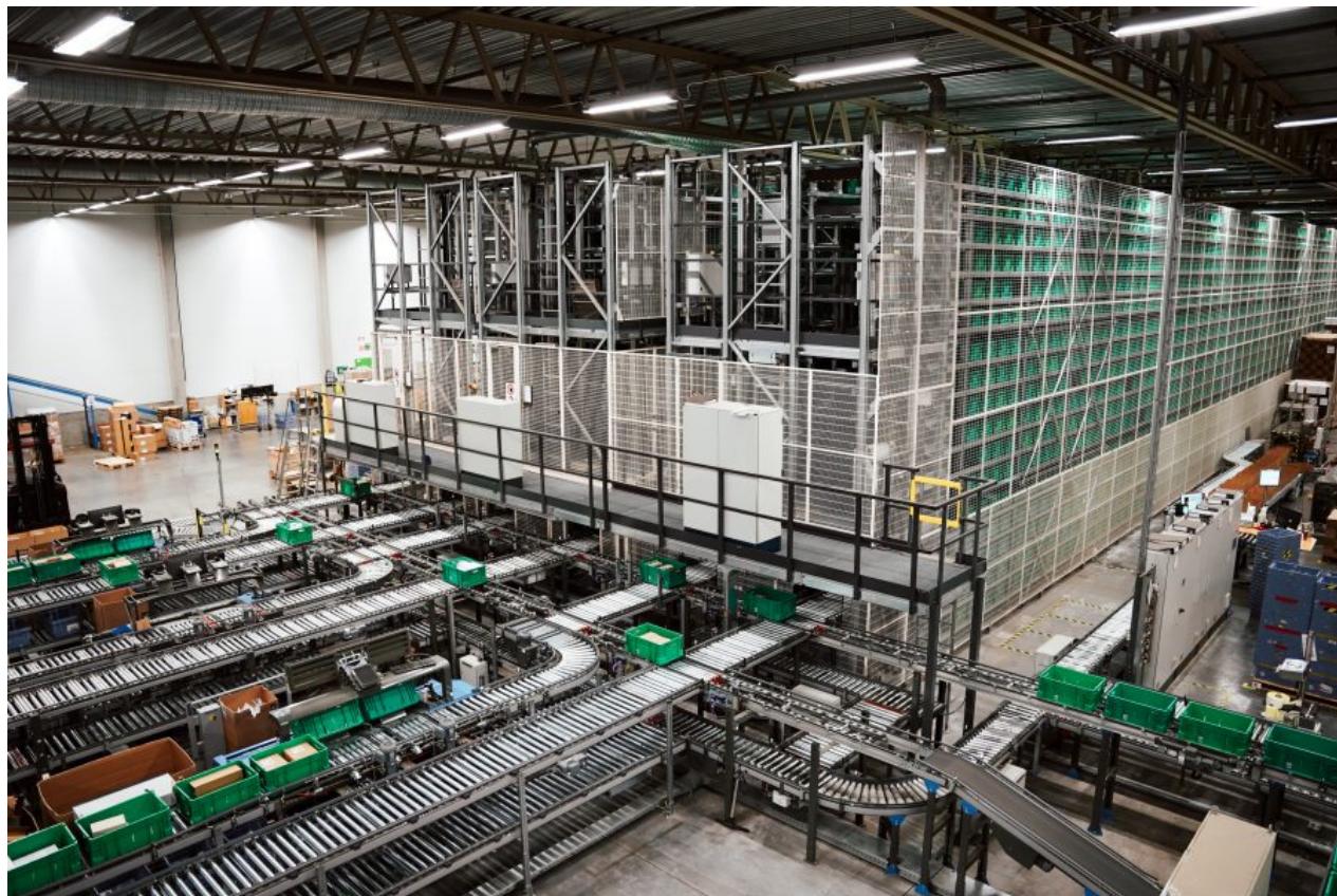
Turas logistikanläggning i Nässjö. Källa: Tura Scandinavia
